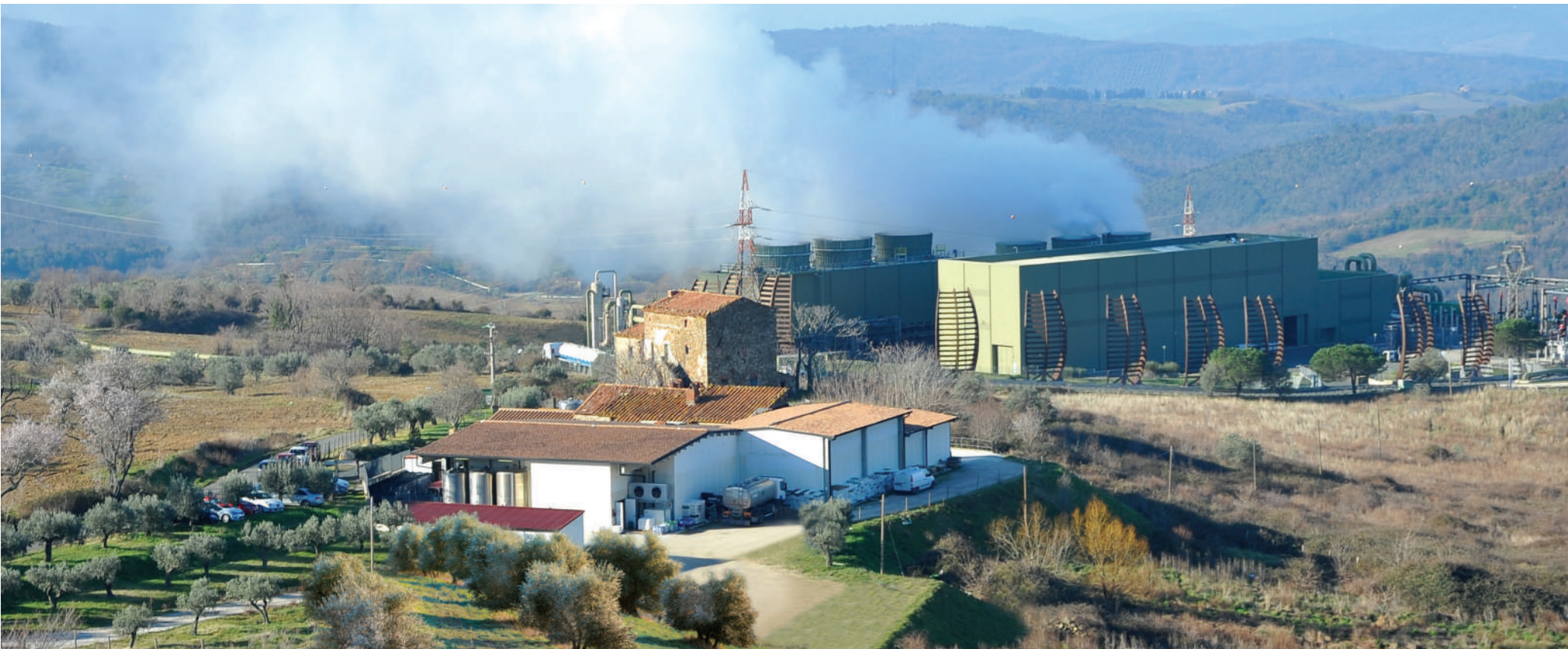
Caseificio San Martino / Centrale geotermica
